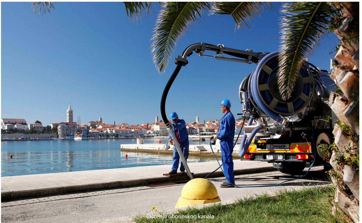
Radovi na sustavu odvodnje
